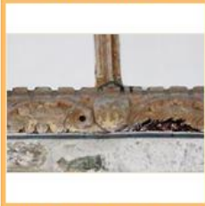
16 North aisle wallplate.JPG
