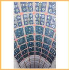
15 Chancel & nave ceiling.JPG
